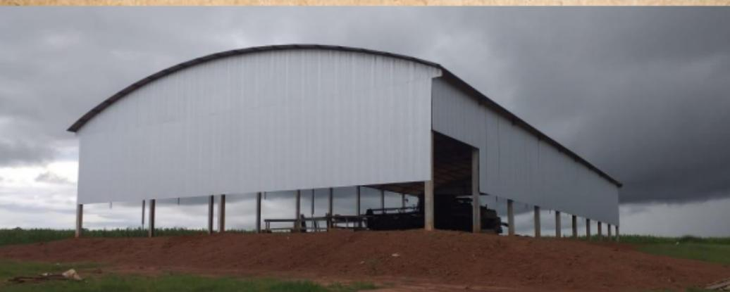
Estrutura metálica parafusada feita sob medida.
